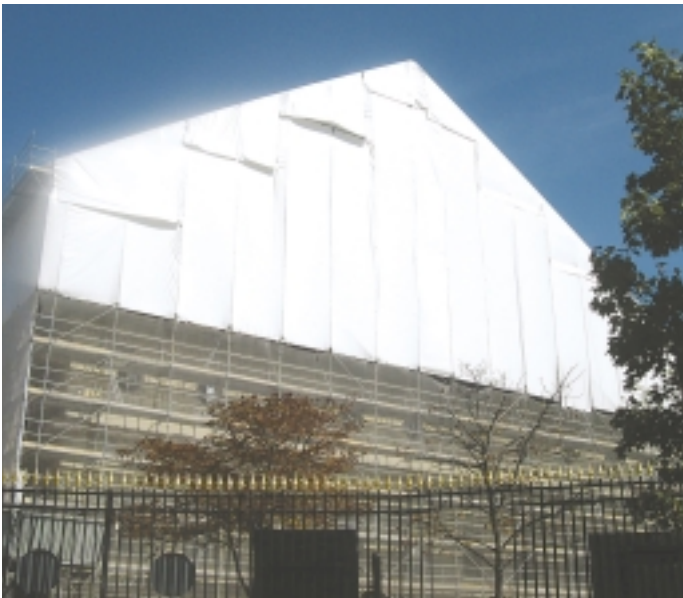
Echafaudage recouvert d'une bâche
